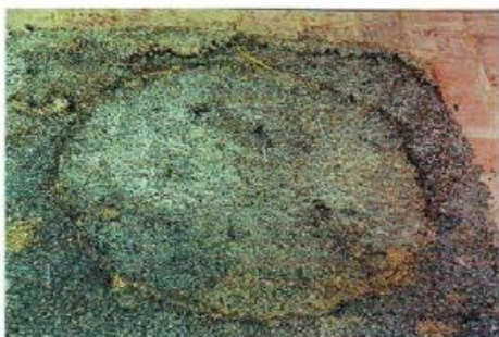
Réalisation, au sein de l'écurie Shalt, sur les plaques d'égouts sécurisant le passage des chevaux
